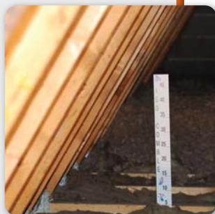
• Soufflage des flocons de laine minérale sur toute la surface des combles et mise en place de la fiche de traçabilité précisant la date d'intervention, la quantité de produit mis en œuvre, et le nom des techniciens.
